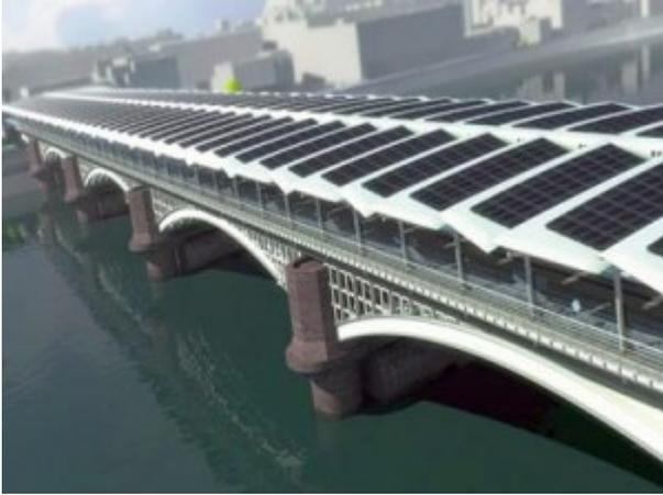
4.400 pannelli fotovoltaici che forniscono la metà dell'energia necessaria per la stazione ferroviaria di Blackfriars
